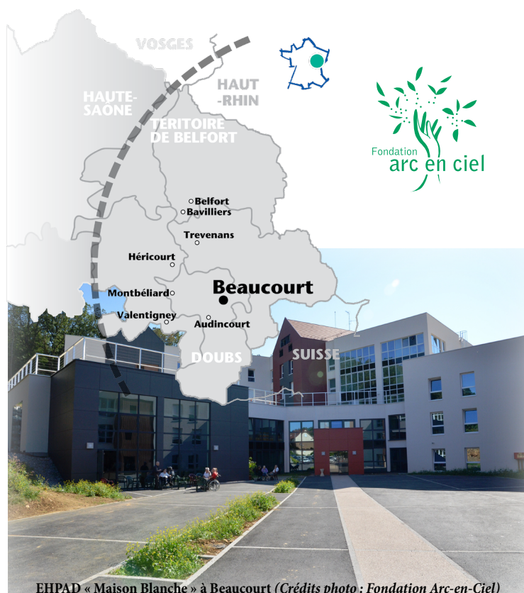
EHPAD « Maison Blanche » à Beaucourt (Crédits photo : Fondation Arc-en-Ciel)
