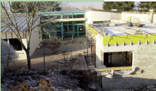
Travaux d'extension de la MAS du "Village Vert" au Breuil.
